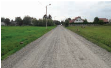
Modernizacja drogi w Aleksandrówce
