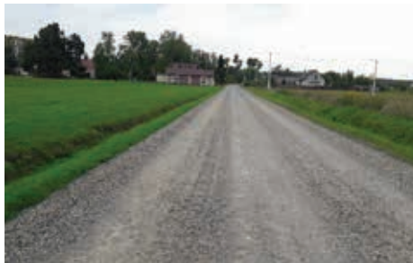
Modernizacja drogi w Celinowie
