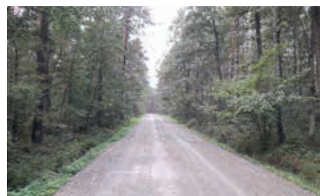
Modernizacja drogi w Rudzie
