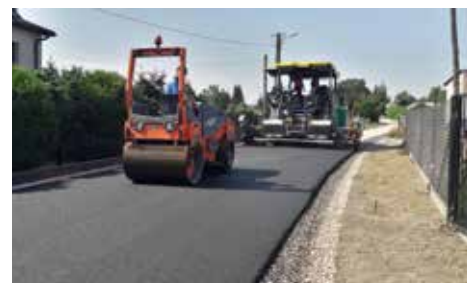
Fot. Prace drogowe na drodze w miejscowości Choszczówka Stojecka
