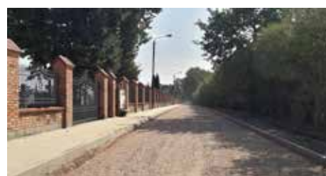
Fot. Prace drogowe na ul. 103 Batalionu Strzelców w Aleksandrówce
