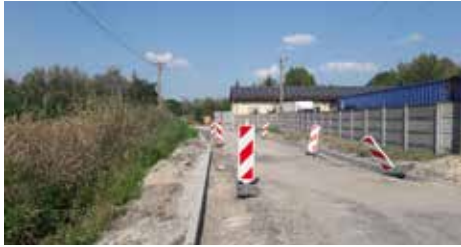
Fot. Prace drogowe na ul. Brukowej w Olesinie (odcinek na północ od autostrady A2)
