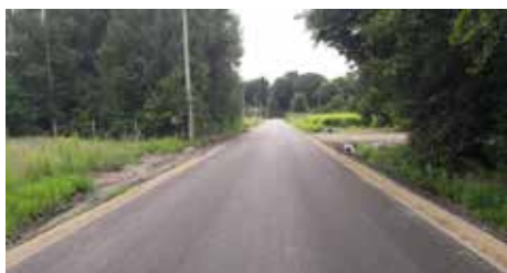
Fot. Prace drogowe na drodze w Teresławiu
