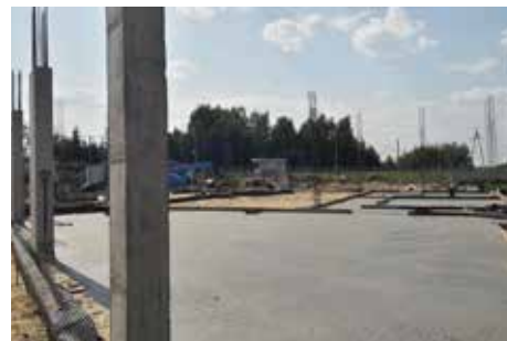
Fot. Prace budowlane związane z budową Strażnicy OSP w Dębem Wielkim
