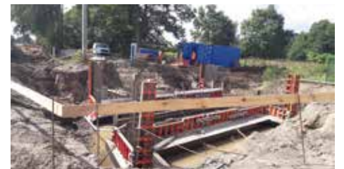
Fot. Prace drogowe przy moście w ul. Batalionu Parasol w Dębem Wielkim
