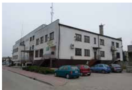
Obiekt Urzędu Gminy Dębe Wielkie: stan przed termomodernizacją
