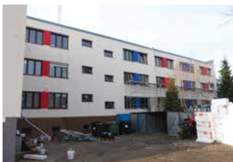
Obiekt Urzędu Gminy Dębe Wielkie: stan w trakcie termomodernizacji
