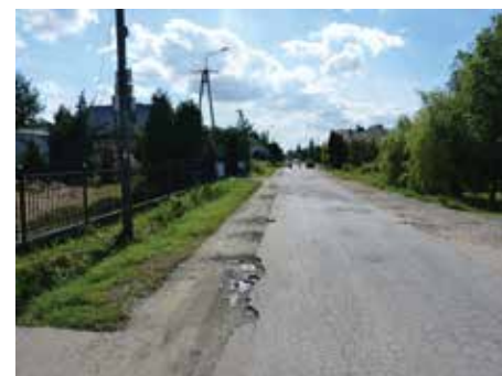
Modernizacja ul. Prądyńskiego w Dębem Wielkim – I etap – droga przed modernizacją
