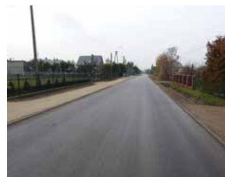
Modernizacja ul. Prądyńskiego w Dębem Wielkim – I etap – droga po modernizacji
