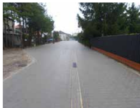
Ciąg pieszo-jezdny w ul. Krótkiej w Dębem Wielkim po rozbudowie i przebudowie
