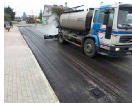
Modernizacja ul. Prądyńskiego w Dębem Wielkim I etap – skropienie nawierzchni asfaltem
