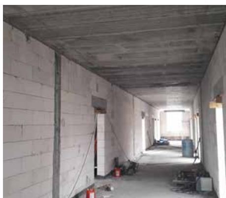
Fot. Roboty budowlane – Szkoła Podstawowa w Górkach
