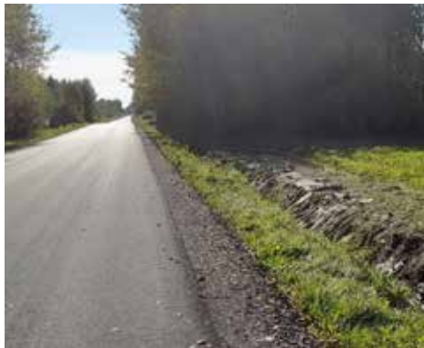
Fot. Przebudowa odcinka drogi gminnej 220229W w miejscowości Celinów, gmina Dębe Wielkie” (ul. Tymiankowa)
