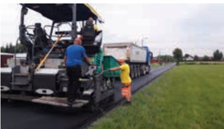
Fot. Prace drogowe na ul. Długiej w Aleksandrówce
