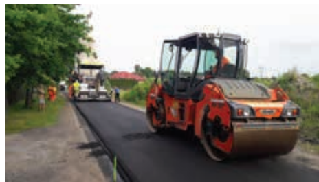
Fot. Prace drogowe na ul. Szklarniowej w Olesinie
