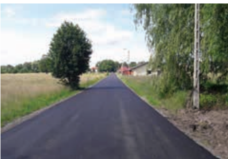
Fot. ul. Długa w Aleksandrówce po wykonaniu nakładki asfaltowej
