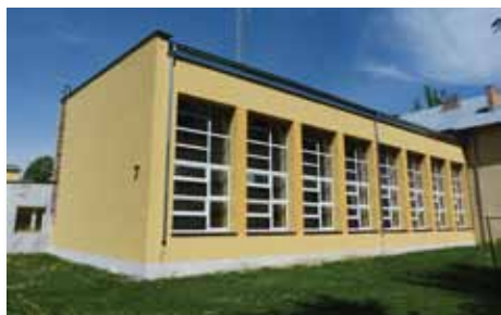
Obiekt Szkoły Podstawowej w Rudzie: W trakcie termomodernizacji
