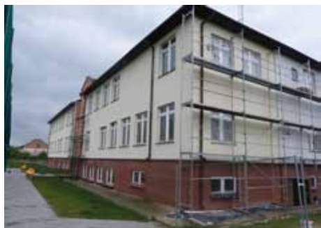
Obiekt Szkoły Podstawowej w Cygance: Prace termomodernizacyjne
