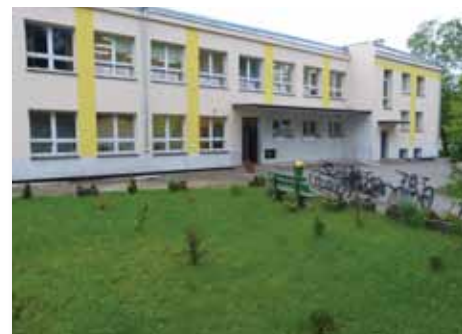
Obiekt Szkoły Podstawowej w Dębem Wielkim: W trakcie termomodernizacji
