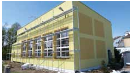
Obiekt Szkoły Podstawowej w Górkach: Prace termomodernizacyjne
