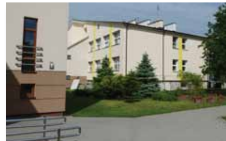
Obiekt Gimnazjum w Dębem Wielkim: W trakcie termomodernizacji
