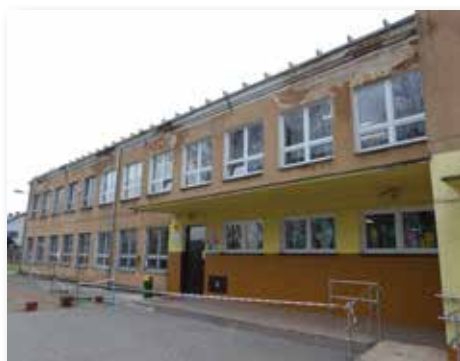
Obiekt Szkoły Podstawowej w Dębem Wielkim: stan przed termomodernizacją
