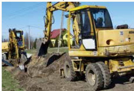
Budowa sieci wodociągowej na terenie Gminy Dębe Wielkie
