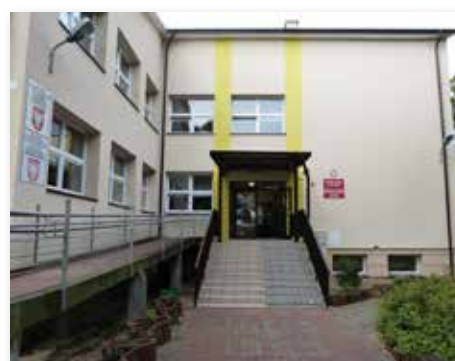
Obiekt Gimnazjum w Dębem Wielkim: stan po termomodernizacji
