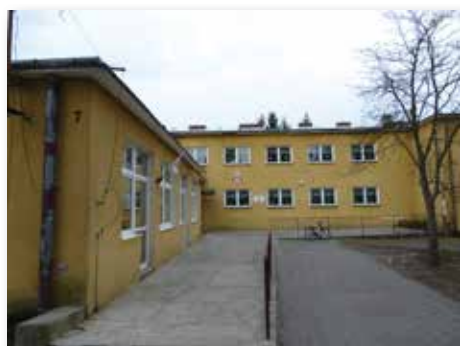
Obiekt Szkoły Podstawowej w Rudzie: stan przed termomodernizacją
