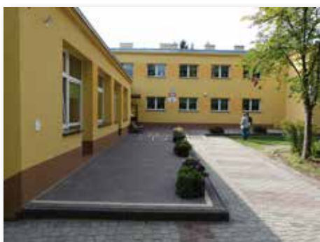
Obiekt Szkoły Podstawowej w Rudzie: stan po termomodernizacji
