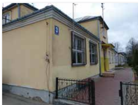
Obiekt Szkoły Podstawowej w Górkach: stan przed termomodernizacją
