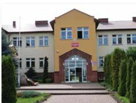
Obiekt Szkoły Podstawowej w Cygance: stan po termomodernizacji
