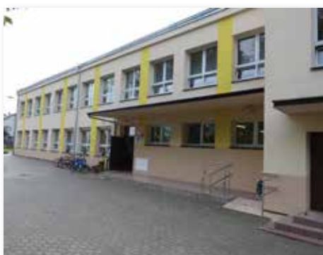
Obiekt Szkoły Podstawowej w Dębem Wielkim: stan po termomodernizacji
