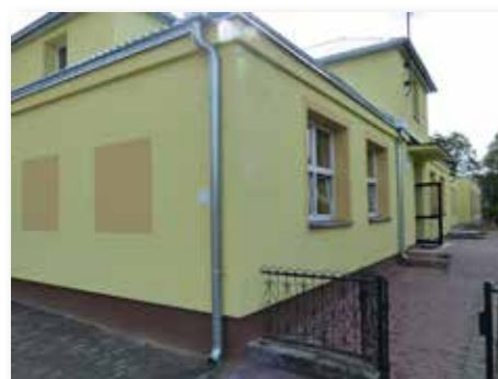
Obiekt Szkoły Podstawowej w Górkach: stan po termomodernizacji
