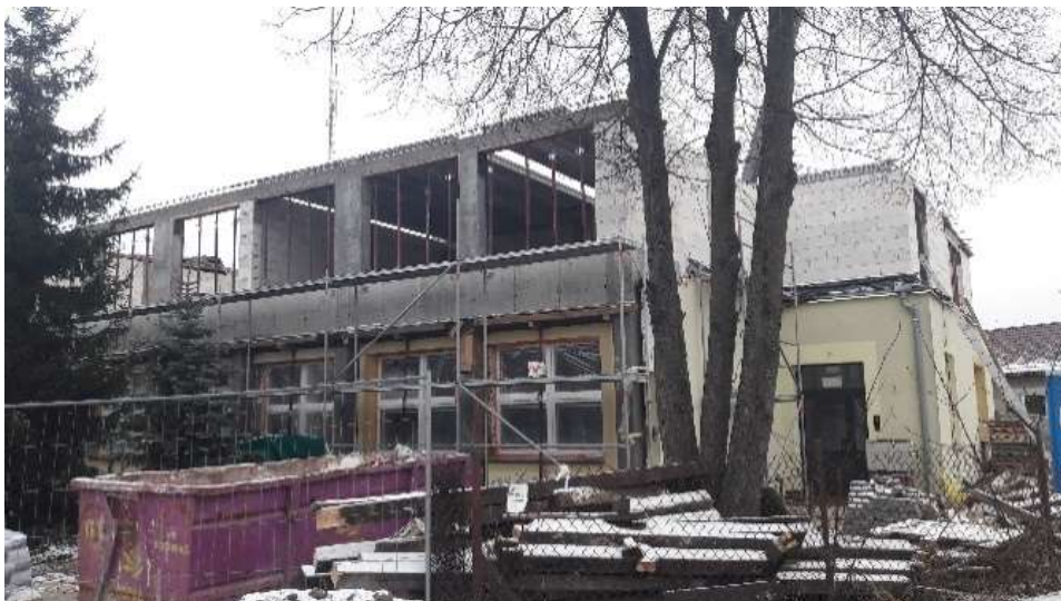
Fot. Roboty budowlane – Szkoła Podstawowa w Górkach
